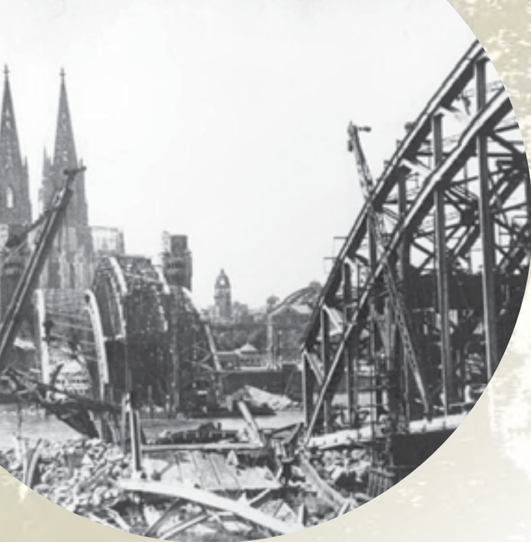
Cầu Hohenzollern bị phá hủy nhìn ra nhà thờ, Cologne 1945. Nguồn: https://commons.wikimedia.org/wiki/File:Bundesarchiv_B_145_Bild-P008041_K%C3%B6ln_Hohenzollernbr%C3%BCcke_nach_Bombenangriff.jpg
